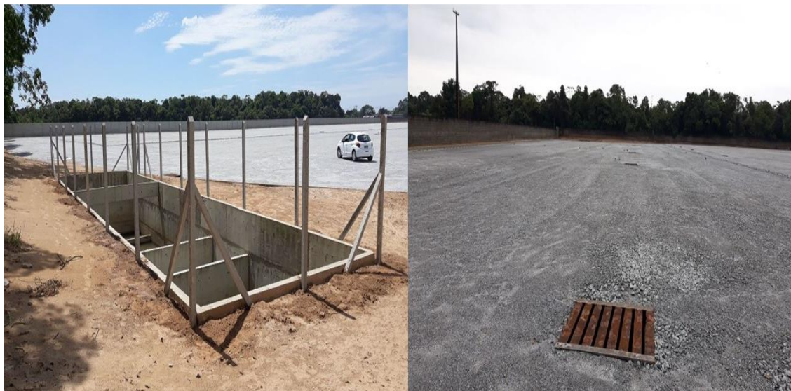
Figura 16 Sistema de drenagem implantado na Araguaia.
